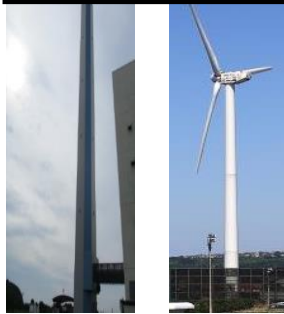
メルトタワー21煙突(100m)
