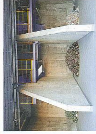
■ カレットストックヤード 廃物を除去したガラスびんを貯留します。
