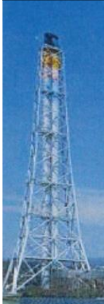
ほくでんだ てはつでんしよえんとつ 北電伊達発電所煙突(200m)
